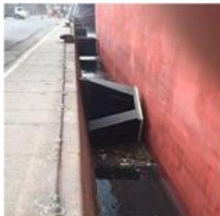
*Figura 1 - Defesa danificada. Item a ser constatado e relatado.*
