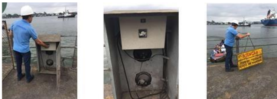
Figura 8 - Alteração da sinalização semafórica no canal do mercado, e posicionamento de placa “proibindopassagem”
